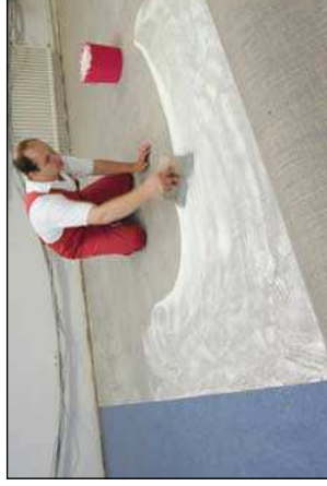
Нанесение клея
