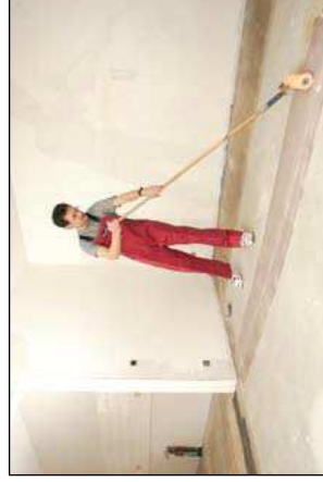
Грунтование стяжки
